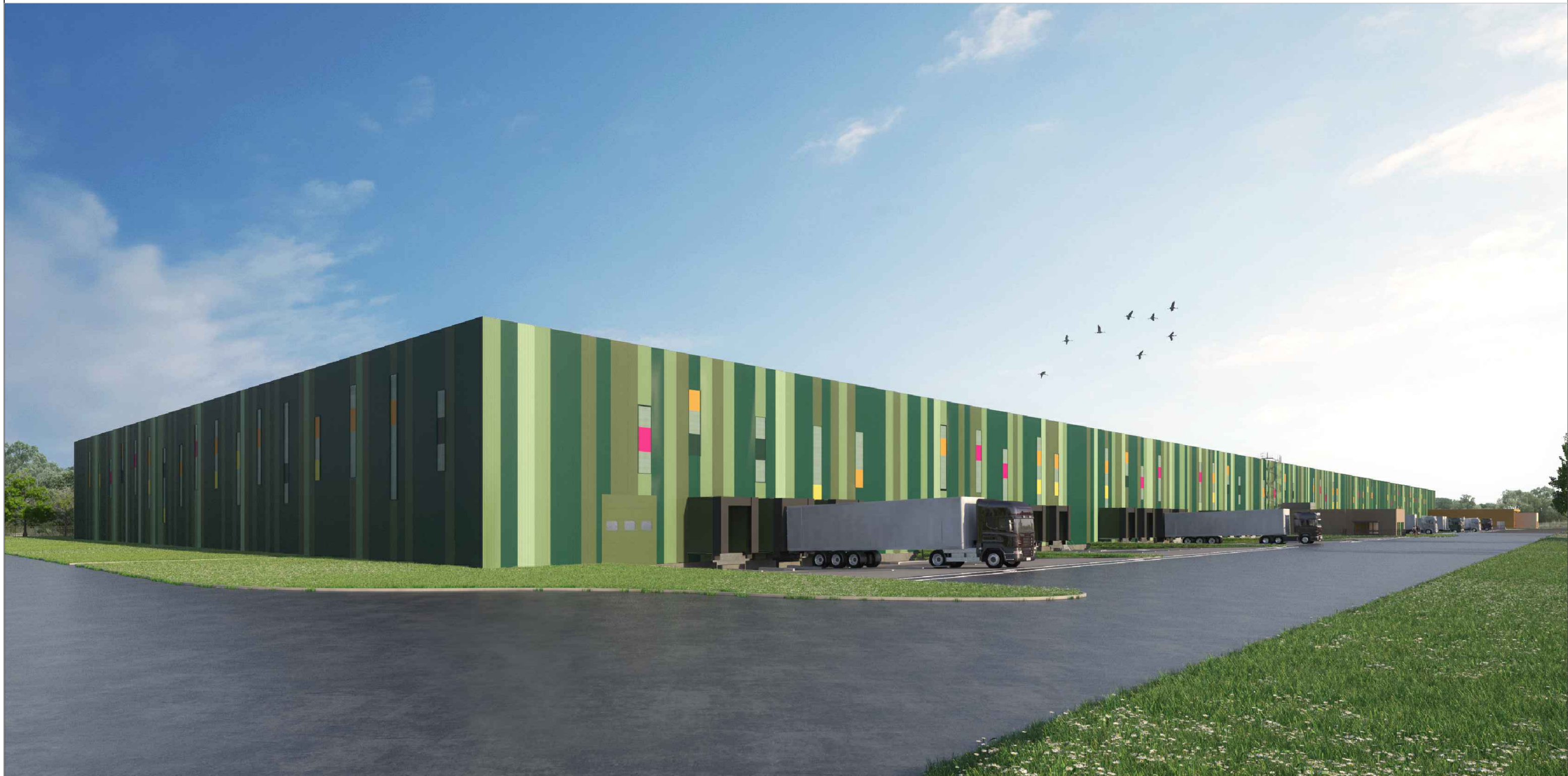
Vue sur façades Nord et Est d'entrepot et bâtiment Bureaux/Locaux sociaux
